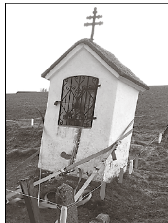
Die Kapelle vor der dringenden Sanierung
