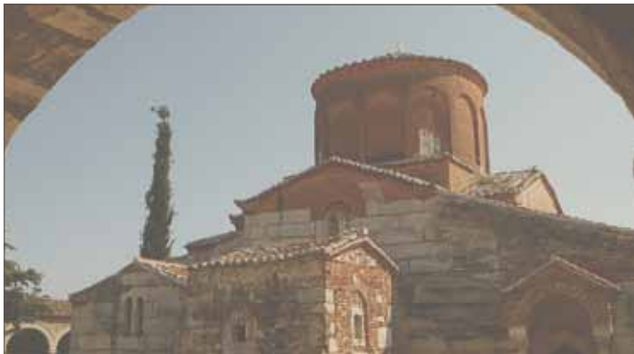
585 v. Chr. gründeten die Korinther die Kolonienstadt Apollonia in Illyrien (Albanien) an der Via Egnatia. Durch Erdbeben wurde sie von der Adria abgeschnitten und aufgegeben. Von 4 Kilometern Stadtmauer und imposanten Gebäuderesten ist nur das später errichtete orthodoxe Kloster gut erhalten.
