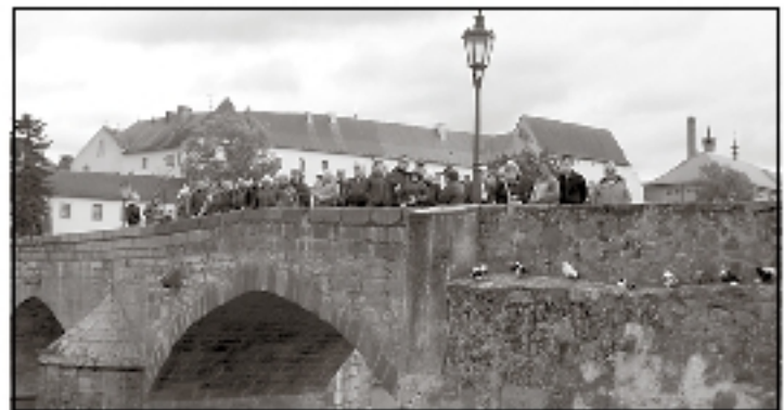
Auf der Steinbrücke von Pisek: Sie ist älter als die Karlsbrücke in Prag.
