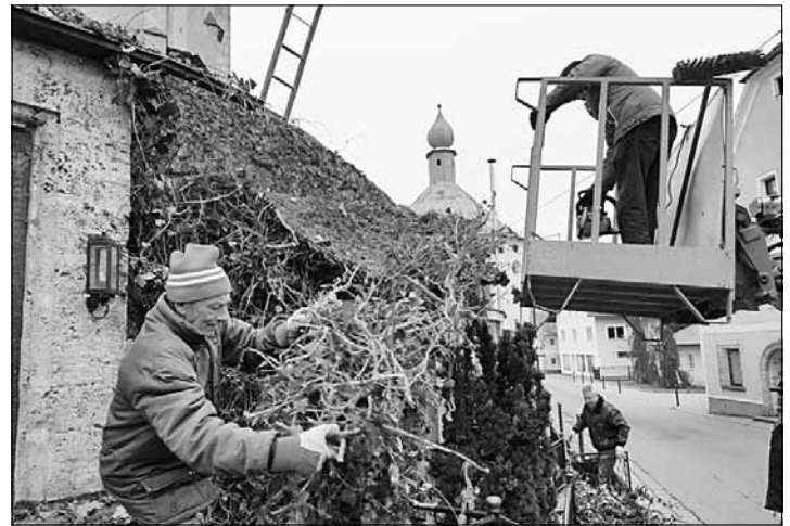
Die Kraft des Efeus hatte bereits die Dachkonstruktion des Kriegerdenkmals gesprengt.
