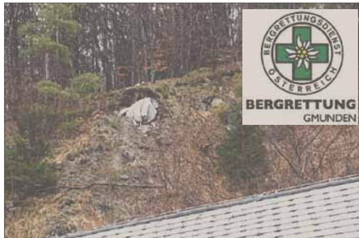
Bedrohlich hing der mehrere Tonnen schwere Fels im Steilhang oberhalb des Gebäudes der Bergretter.
