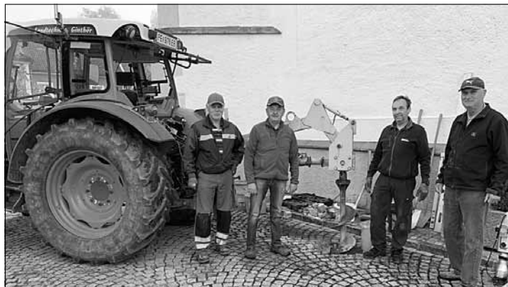
Die Kameraden Josef Larch, Herbert Möseneder, Hubert Eberl und Heinrich Hochstöger beim Einbau des Ankerrohrs für den neuen Fahnenmasten
